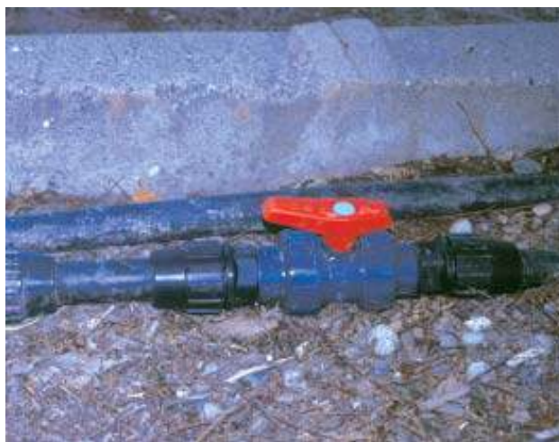
Figura 13. Válvula de esfera.
