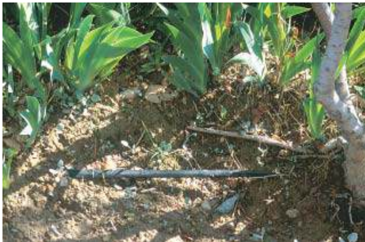
Figura 3. El crecimiento de las raíces sobre las tuberías de riego subterráneo puede dar lugar al estrangulamiento de las mismas.
