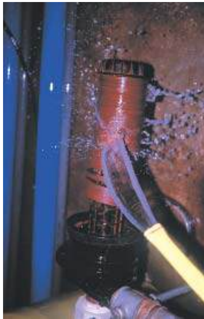
Figura 8. Limpieza manual de un filtro de anillas.
