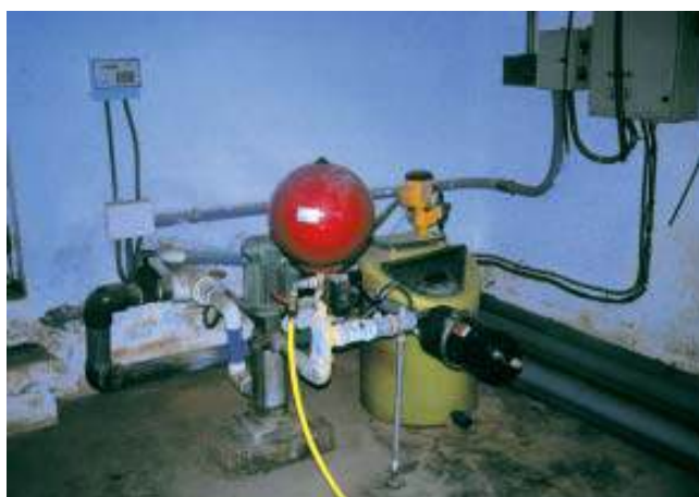
Figura 6. Cabezal de riego
