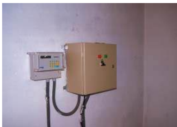
Figura 6. Programador a pilas (a la izquierda) y programador alimentado por corriente eléctrica.
